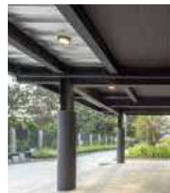
บริการติดตั้ง (Erection)
