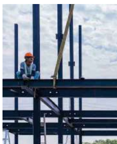
บริการติดตั้ง (Erection)
